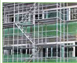
시스템 비계 설치
